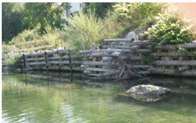
Lesena kašta s kaštnimi jezbicami na Savinji (Foto: P. Repnik Mah, 2012)
