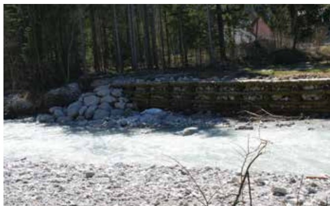
Lesena kašta ali kranjska stena na Savi Dolinki (Foto: P. Repnik Mah, 2013)
