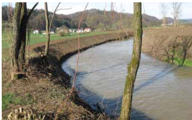
Sonaravno urejen odsek takoj po izvedbi (Foto: S. Jokanović, 2010)
