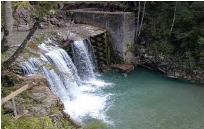
Prodna pregrada pred obnovo (Foto: R. Fazarinc, 2002)
