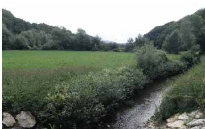
Vzpostavljena obrežna zarast na Šmarskem potoku po ureditvi (Foto: S. Jokanovič, 2013)
