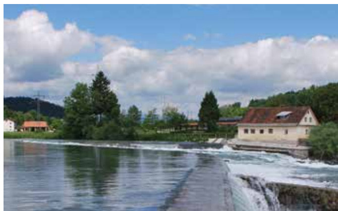
Jez z obnovljeno ribjo stezo (na sredini) (Foto: P. Repnik Mah, 2013)
