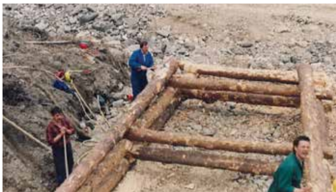
Gradnja lesenih kaštnih jezbic na Savinji (Foto: R. Fazarinc, 1992)
