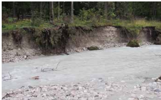
Brežina pred izvedbo zavarovanja (Foto: Ž. Jeriha, 2010)
