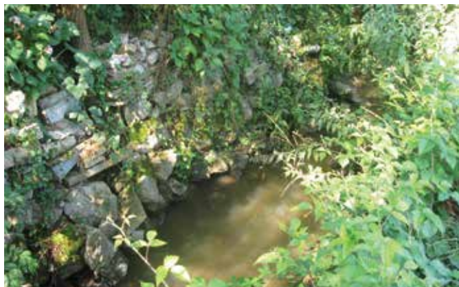
Prvotno obrežno zavarovanje (Foto: Ž. Jeriha, 2010)
