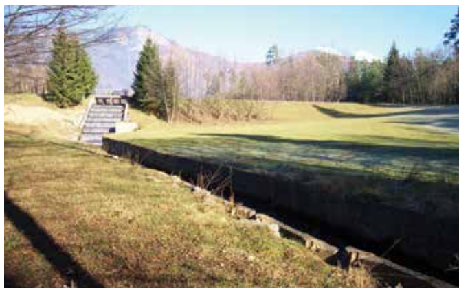
Toga regulacija (pogled gorvodno proti iztočni kaskadi jezera) (Foto: EHO Projekt, 2000)
