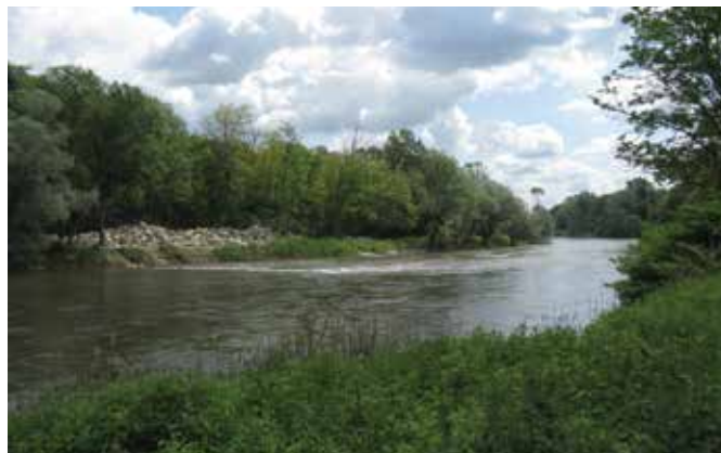
Gradnja drče na Muri (Foto: M. Habinc, 2010)
