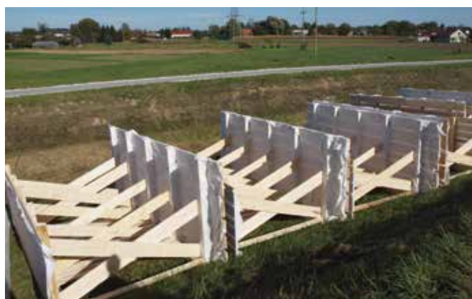
Za vgradnjo pripravljene leseni zaboji, obloženi z geotekstilom (Foto: M. Habinc, 2012)
