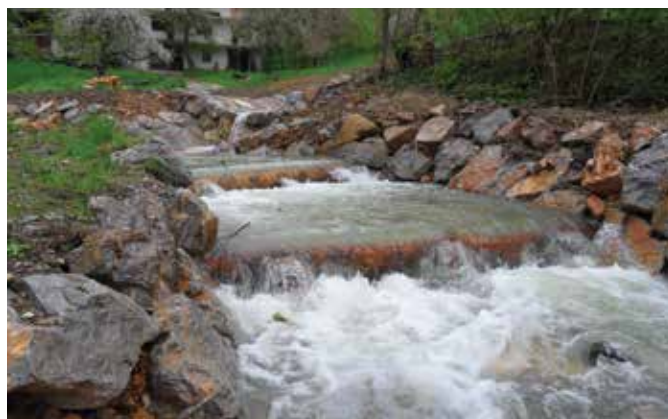
Tik po izvedbi ureditve – kamnito-betonski pragovi (Foto: Ž. Jeriha, 2010)
