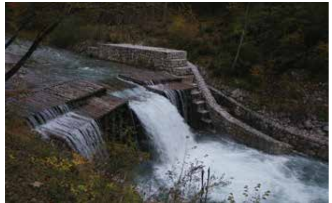
Obnovljena prodna pregrada na Kokri z ribjo stezo (Foto: P. Repnik Mah, 2011)
