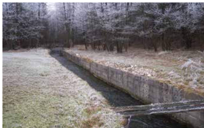
Toga regulacija (pogled dolvodno) (Foto: EHO Projekt, 2000)
