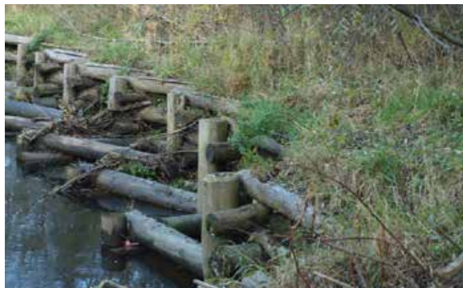
Zavarovanje brežine na Dravinji z leseno kašto (Foto: M. Habinc, 2011)
