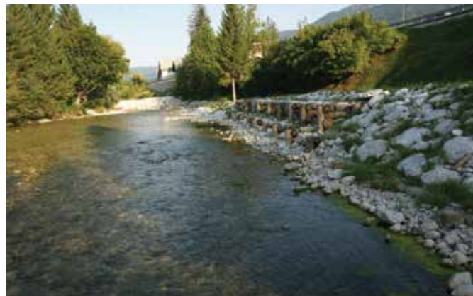
Zavarovanje z leseno kašto – pogled dolvodno (Foto: P. Repnik Mah, 2012)
