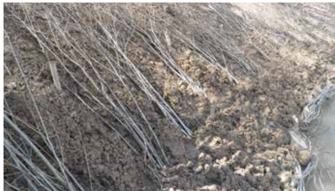
Izvedba sonaravnih tehnik na Šmarskem potoku (Foto: S. Jokanovič, 2013)
