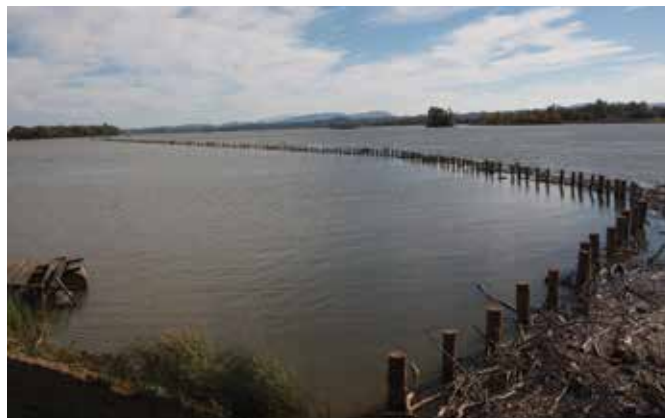
Grablje za zaustavljanje plavja iz lesenih pilotov (Foto: M. Habinc, 2012)
