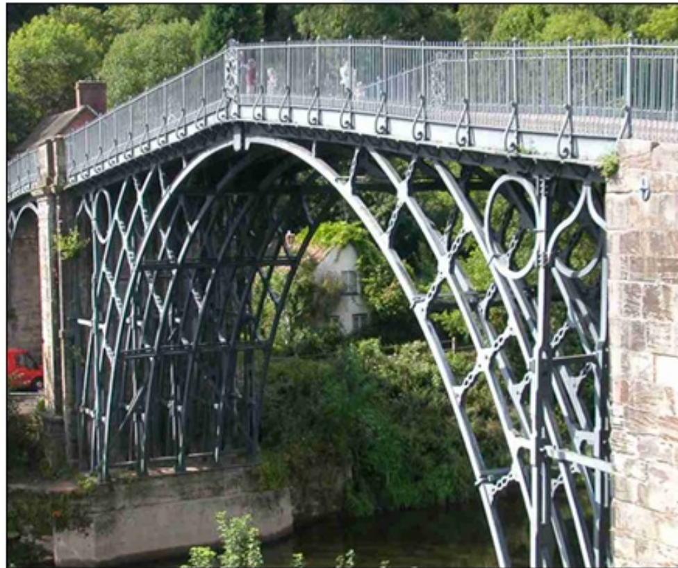
Železni most prek reke Severn je prvi železni most na svetu. Izdelali so ga med leti 1775 in 1779.
