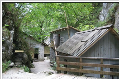
Barake iz bolnišničnega kompleksa Franja
