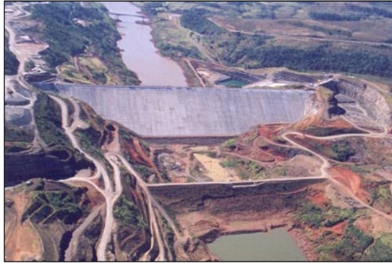
Gradnja hidroelektrarne za oskrbo industrijskih obratov
