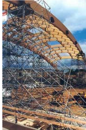
Izdelava ostrešja iz lepljenih nosilcev
