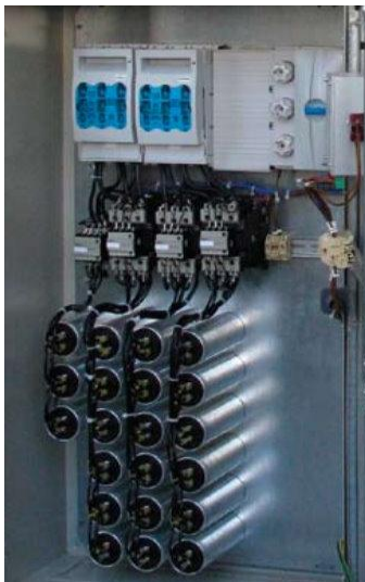
Slika 213: Kondenzatorji za kompenzacijo jalove energije
