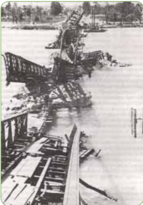
Porušeni most na Ptuj
