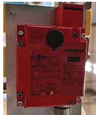
Slika 170: Varnostno stikalo na vratih
