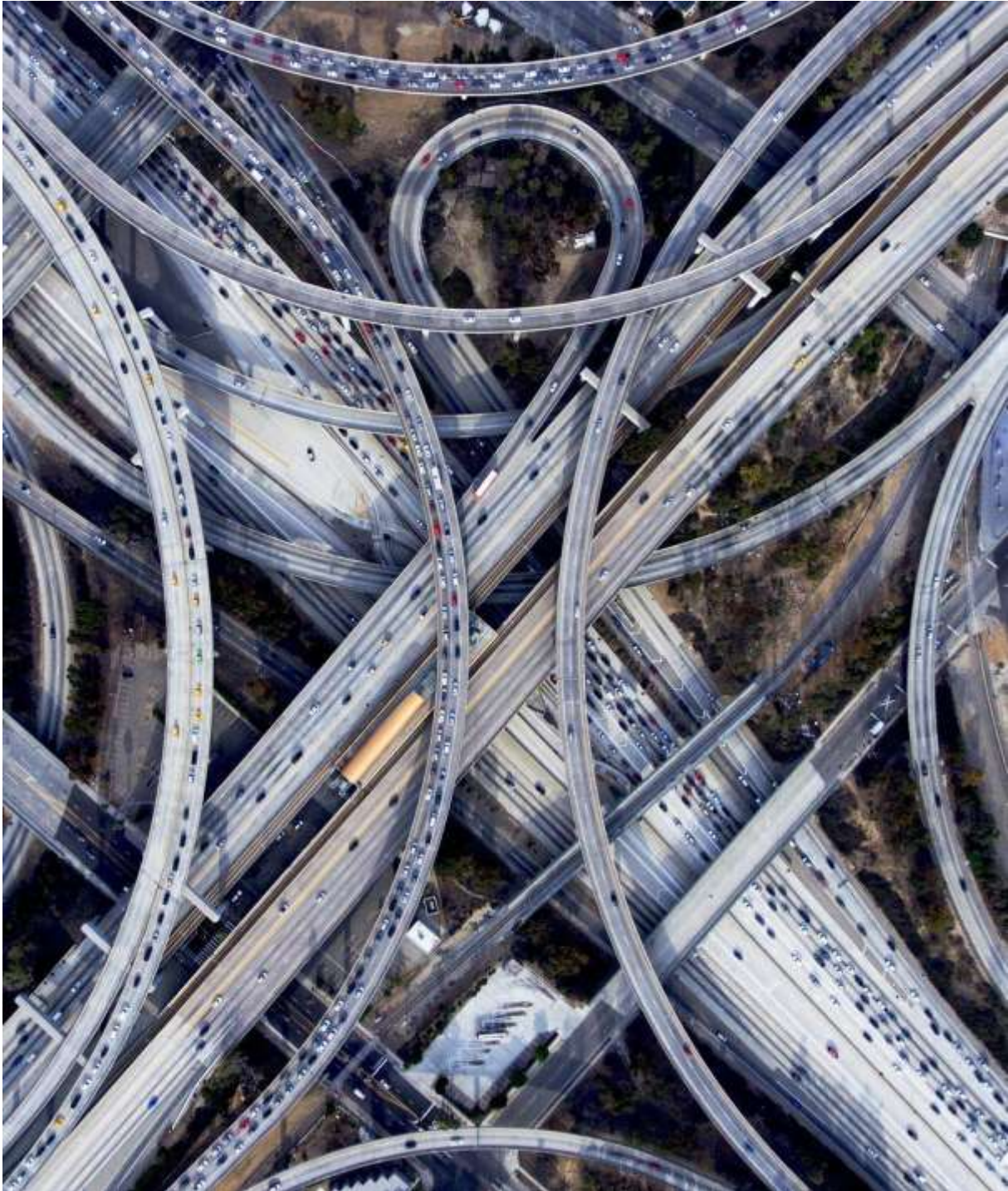
Preplet avtocestnih priključkov v Los Angelesu (ZDA), križanje avtocest 105 in 110.
