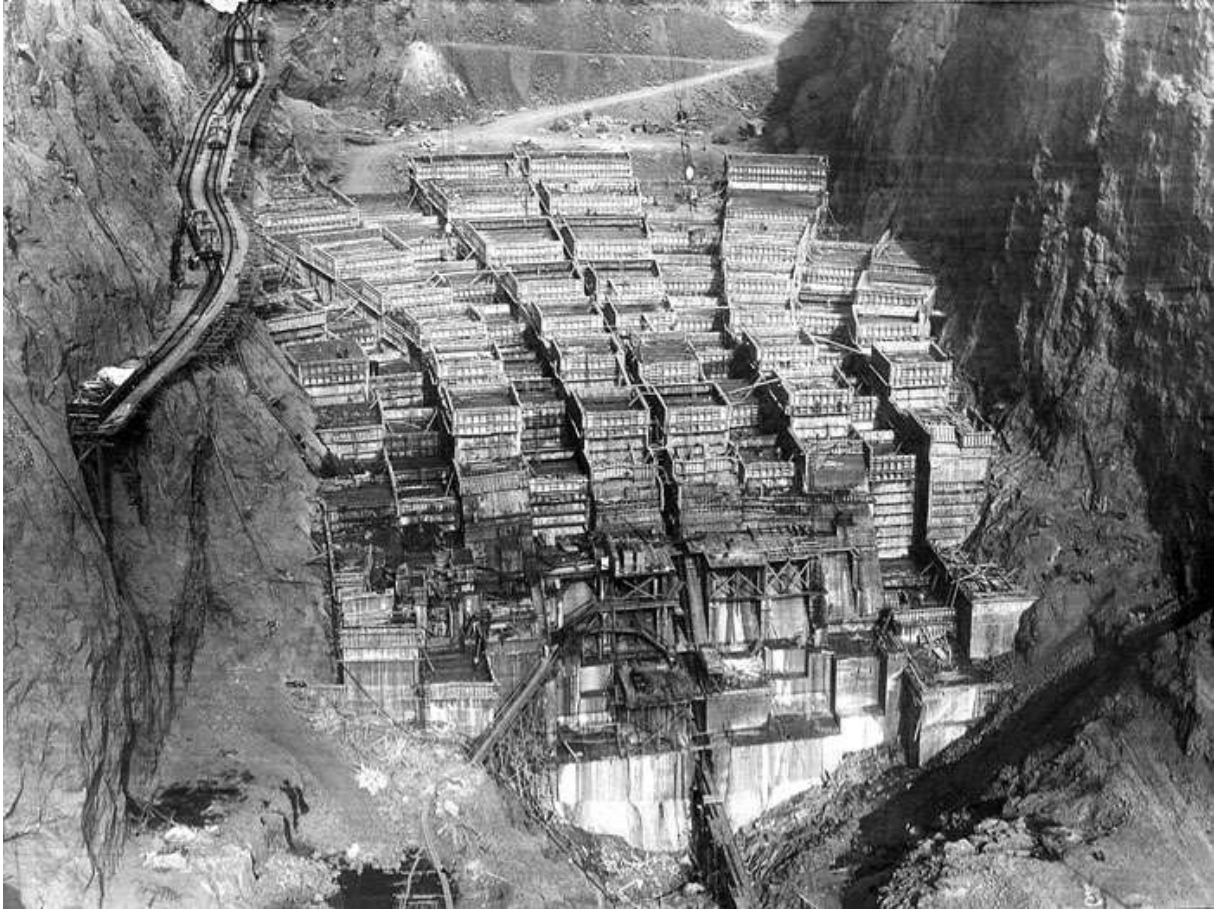
Gradnja jezua Hoover Dam (ZDA) v letih 1931-1936. Višina zidu je 221 metrov.
